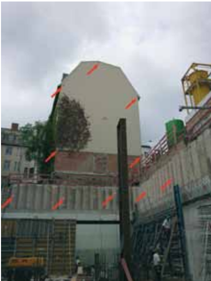
Beispiele für Überwachungspunkte: Reflektorfolien an ausgewählten Punkten eines zu überwachenden Gebäudes (links), fest montierte Prismen an Gebäuden (rechts)
