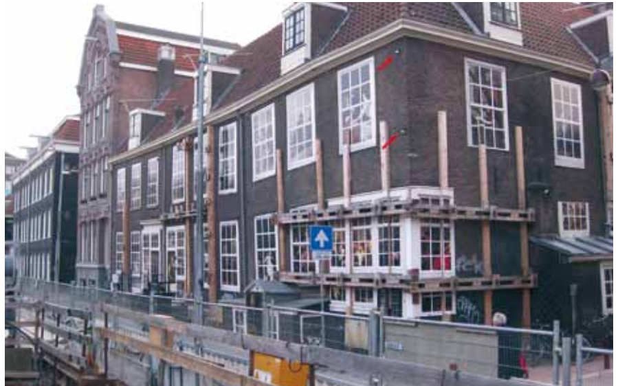
Beispiele für Überwachungspunkte: Reflektorfolien an ausgewählten Punkten eines zu überwachenden Gebäudes (links), fest montierte Prismen an Gebäuden (rechts)
