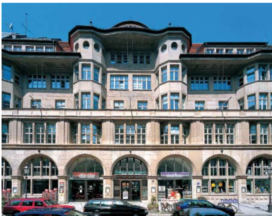
Die denkmalgeschützte Fassade des ehemaligen „SZ-Gebäudes“ bleibt, aber dahinter wird sich bis Ende 2010 viel verändern
